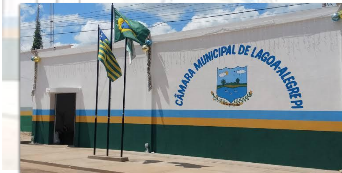
Figura 1 Sede da Câmara Municipal
